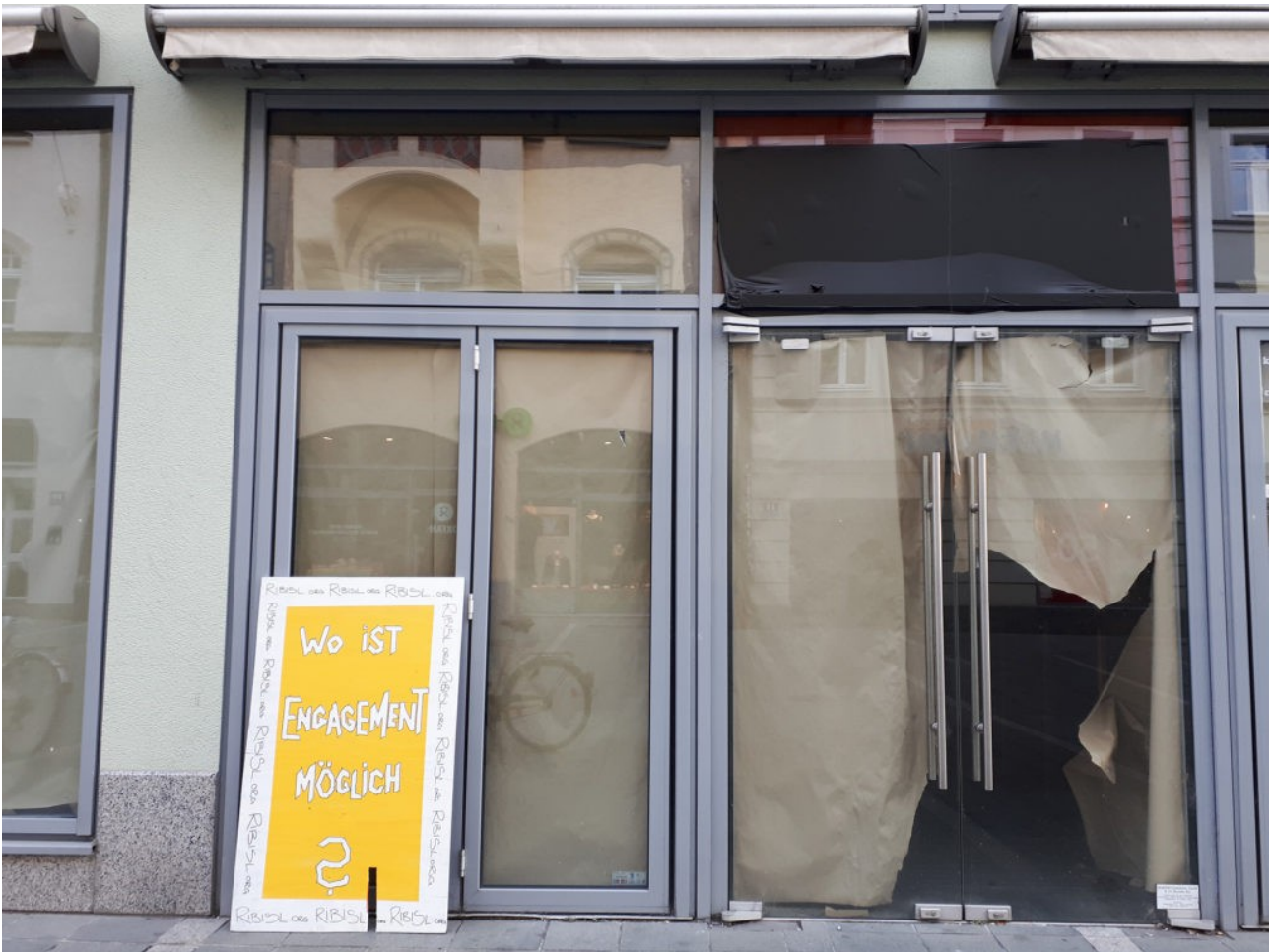
Beispielbild: Teilweise unbefriedigende Zustände in der Maxstraße
