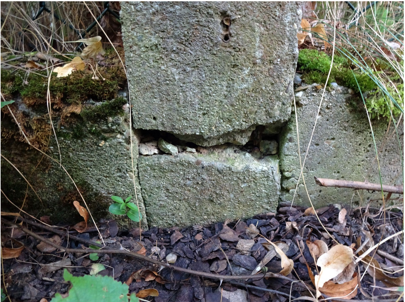
Gefahr im Verzug: Zwei Pfosten sind schon locker, einer hängt schon in den Seilen...
